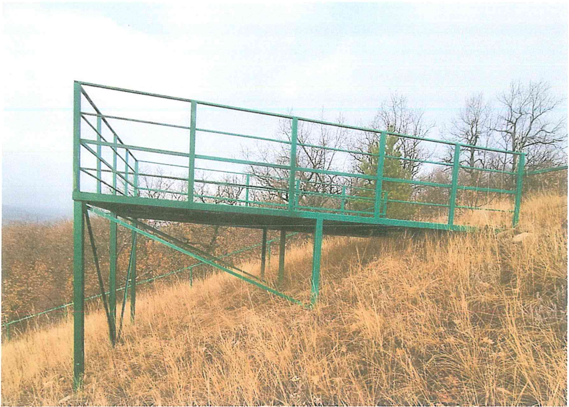
Фото 3. Смотровая площадка на склоне. Автор фото Н.А. Миляева
