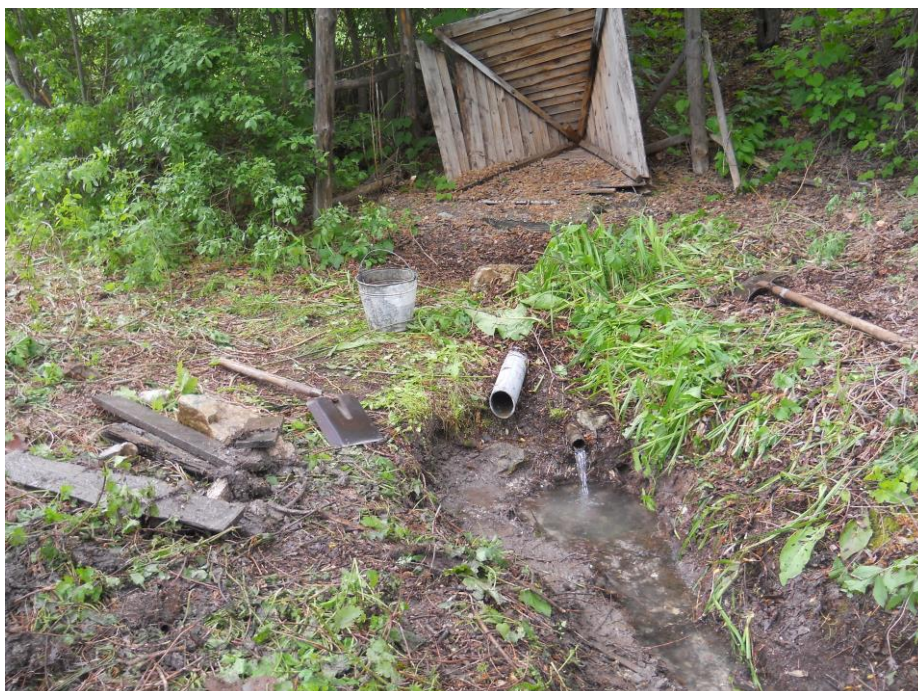
Фото 11. Общий вид расчищенного родника. Под трубой при выходе воды каптаж сложен из бутового камня.
