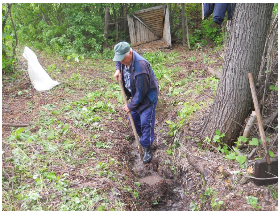
Фото 7. Углубление отводной (дренажной) канавы В.Е. Лавров
