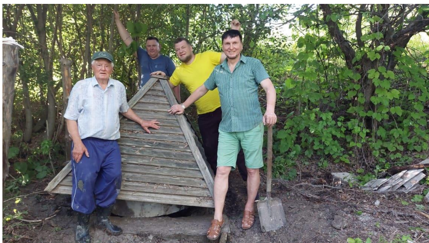
Фото 10. Установили кольцо и забетонировали вокруг. Лавров В.Е., Фомин А., Николаев П.В., Фомин И.Н.
