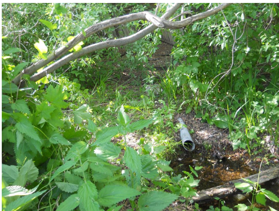
Фото 3. Вид каптажа до реконструкции
